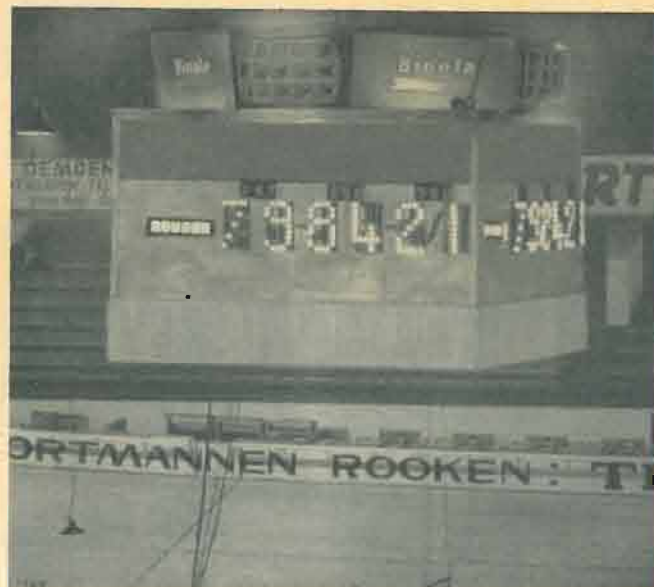
FIG. 1. - I quattro sistemi di altoparlanti sono collocati sopra al tabellone luminoso indicatore delle classifiche disposto al centro della sala a circa 8 m di altezza. Ognuno di essi copre i 90° sul piano orizzontale.
